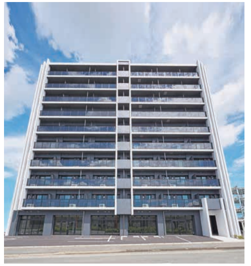
▲GLC GROUPの建築した物件の外観
